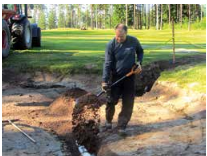
Kuva Pyhän 16. bunkkerien kuivatuksen uusiminen
