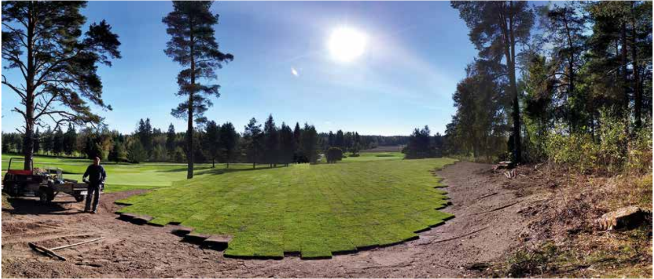
Kuva 14. lyöntipaikan siirtonurmityöt.
