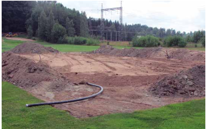
Kuva 5. punainen tee rakenteilla.
