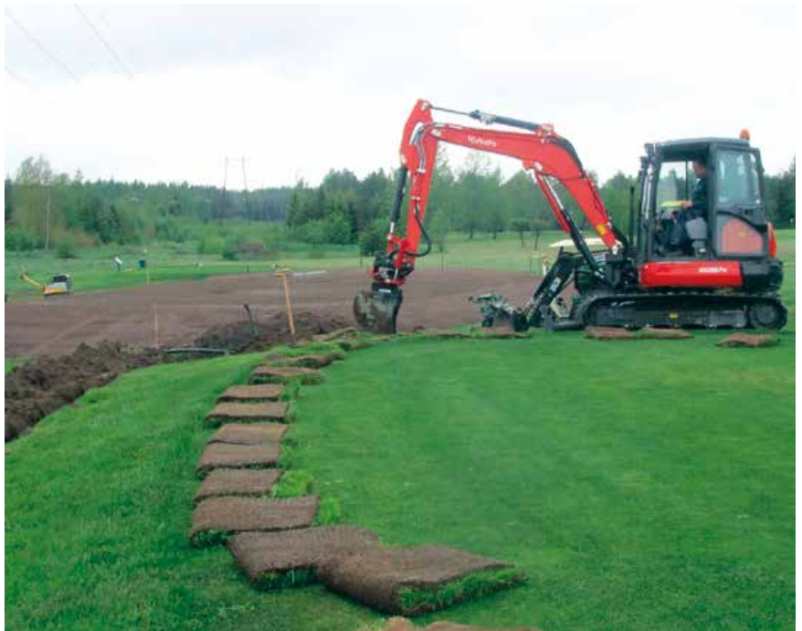
Kuva 8. tee kastelujärjestelmän kaivuuta.
