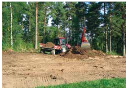
Kuva 14. teen pohjan kaivuu.
