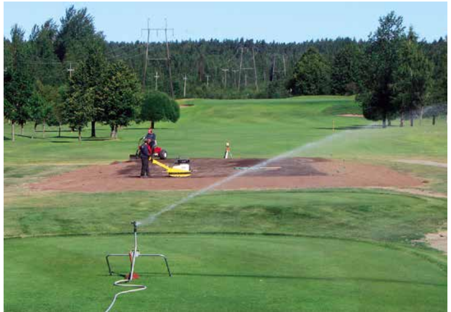
Kuva Työskentelyä 5. teellä.
